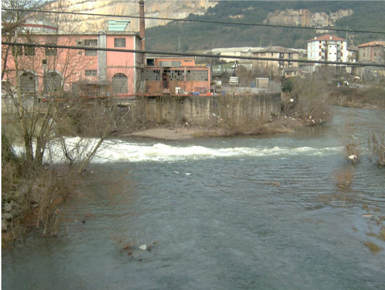
Arratia ibaiak eta Ibaizabal ibaiak egiten duten lekua. bat
